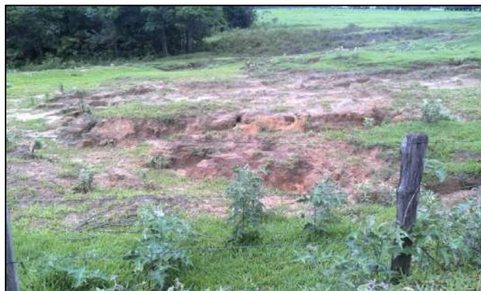
Figura 17 - Ponto crítico de erosão nas margens da estrada.
