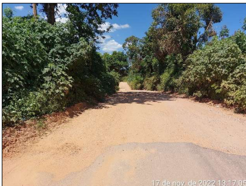
Figura 32 - Vista geral do trecho não pavimentado da estrada rural CAC-020.
