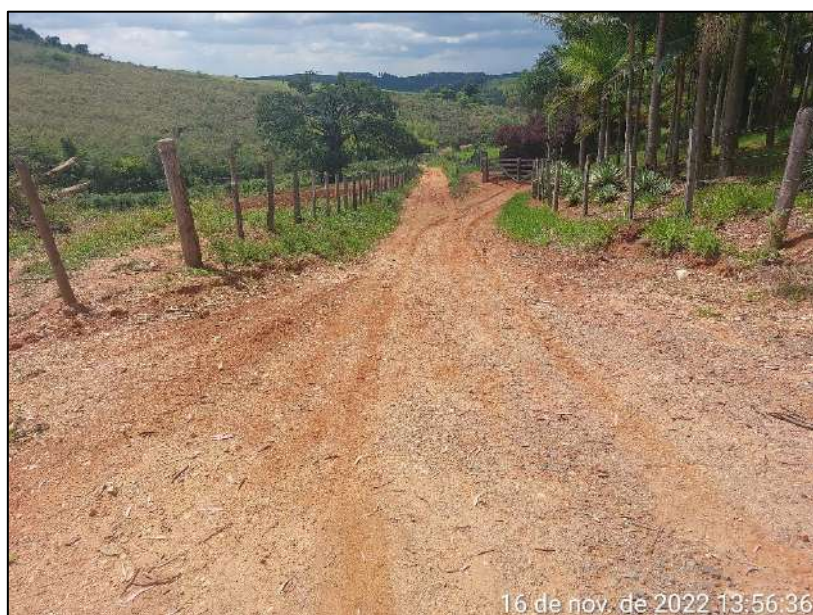
Figura 52 - Vista geral da estrada rural não pavimentada CAC-146.
