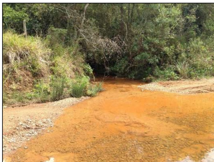
Figura 12 - Ponto crítico de passagem molhada.
