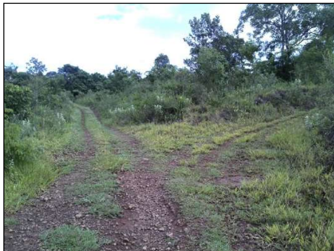
Figura 11 - Ponto crítico de gramíneas no leito carroçável.
